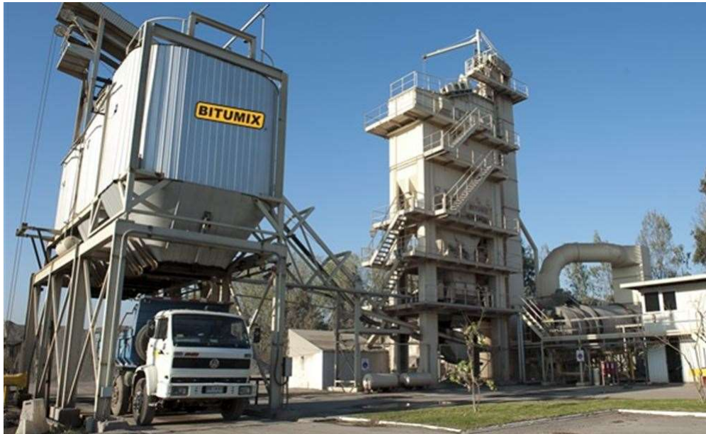
Fuente: Planta Bitumix Maipú
