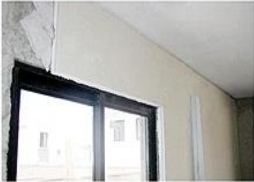
Figura 28: Uniones en L en ventanas.
