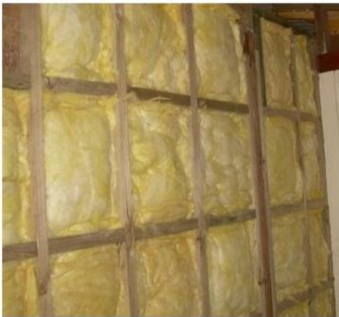
Figura 29: Ejemplo de muro perimetral exterior con aislante de lana de fibra de vidrio.
