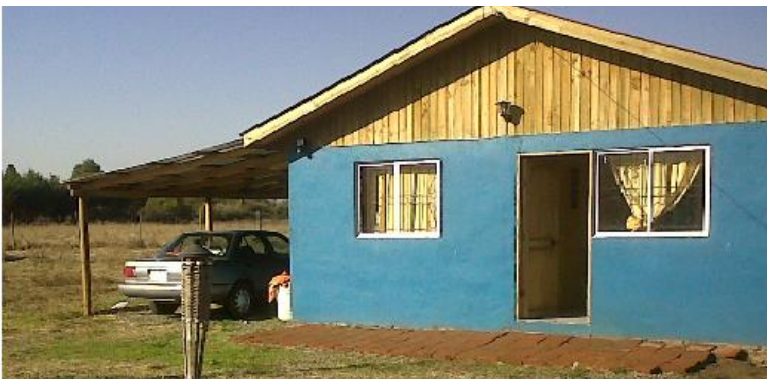
Figura 2: Vivienda tipo 2. Muros de albañilería y cielo de yeso – cartón.
