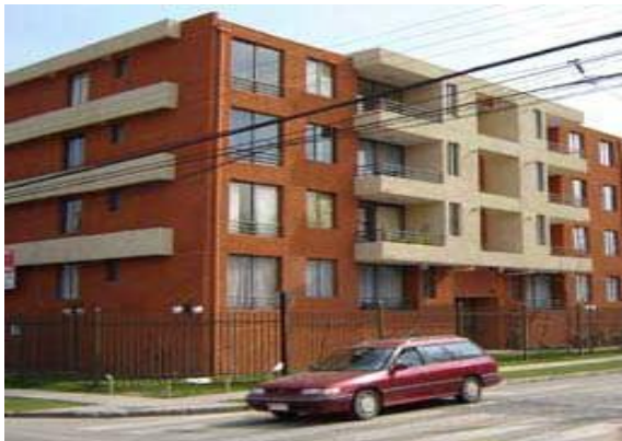
Figura 4: Vivienda tipo 4. Muros de hormigón.
