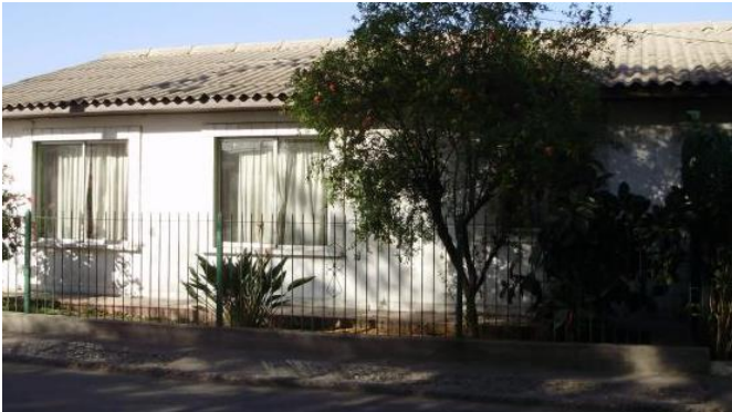
Figura 1: Vivienda tipo 1. Muros de albañilería y cielo de yeso- cartón.
