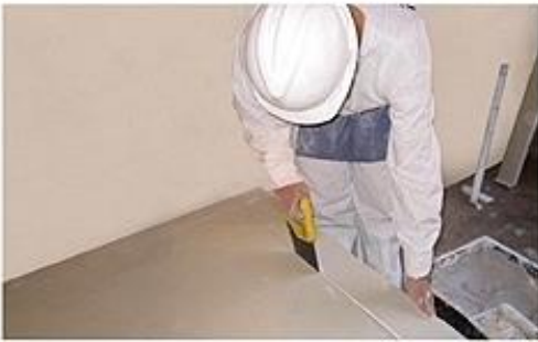
Figura 25: Cortes de las planchas.
