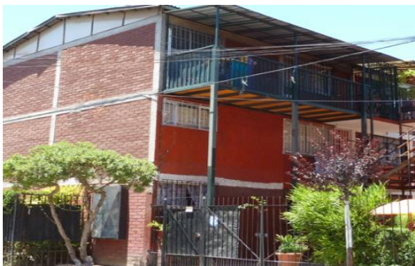
Figura 3: Vivienda tipo 3 con muros de albañilería.
