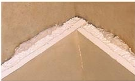
Figura 27: Encuentro de ángulos internos en muros.
