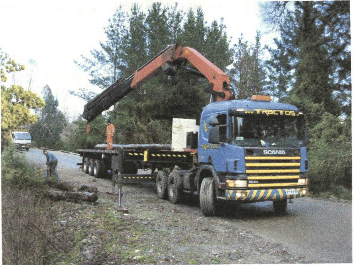
Figura 5: Grúa montada sobre cuello de tractocamión
