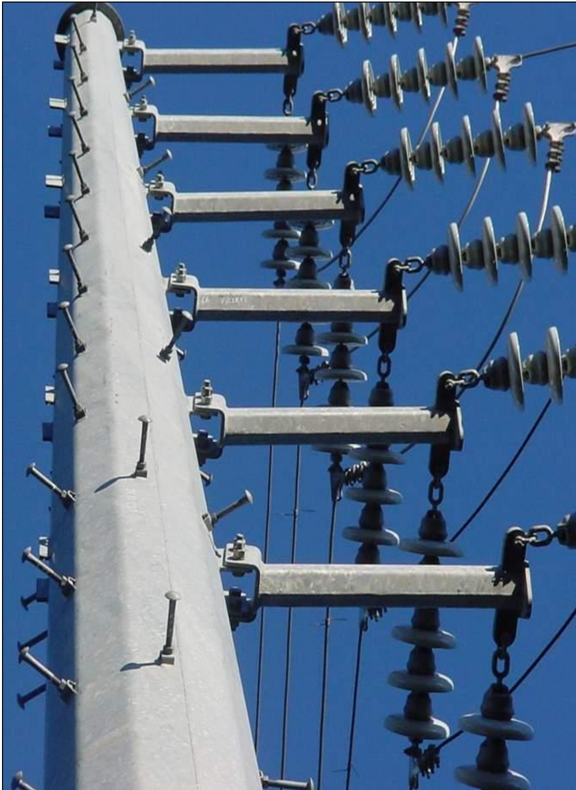
Línea de Transmisión de Alta Tensión.
